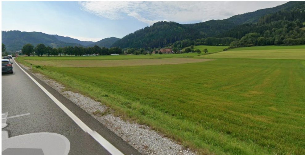
Abb. 48: B317 ca. Kilometer T2,6; Blickrichtung Süden (Quelle: Google Streetview, 06/2025)
