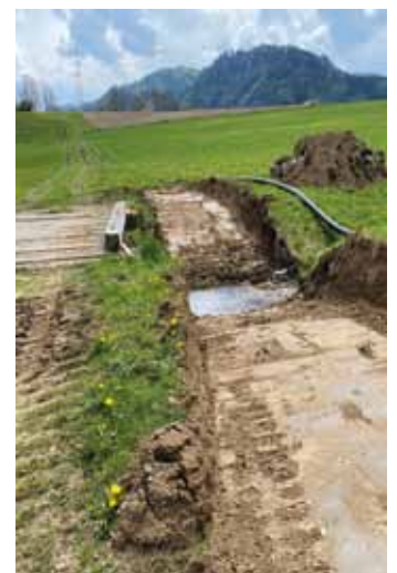
Querung des Mitterdorfbaches.
