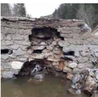
Ende April wurde von der Wildbach- und Lawinverbauung die Sanierung der bröckelnden Grabmoarsperre im Großen Feistritzgraben in Angriff genommen. Diese erfolgt durch Anbringung einer Betonschürze, Erhöhung der Sperrenflügel und Aufweitung der
